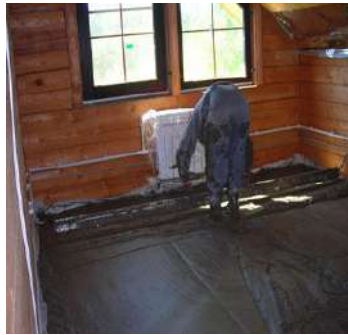
Стяжка пола полусухая, пенобетоном, гипсопенобетоном.
