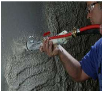
Механизованна штукатурка
